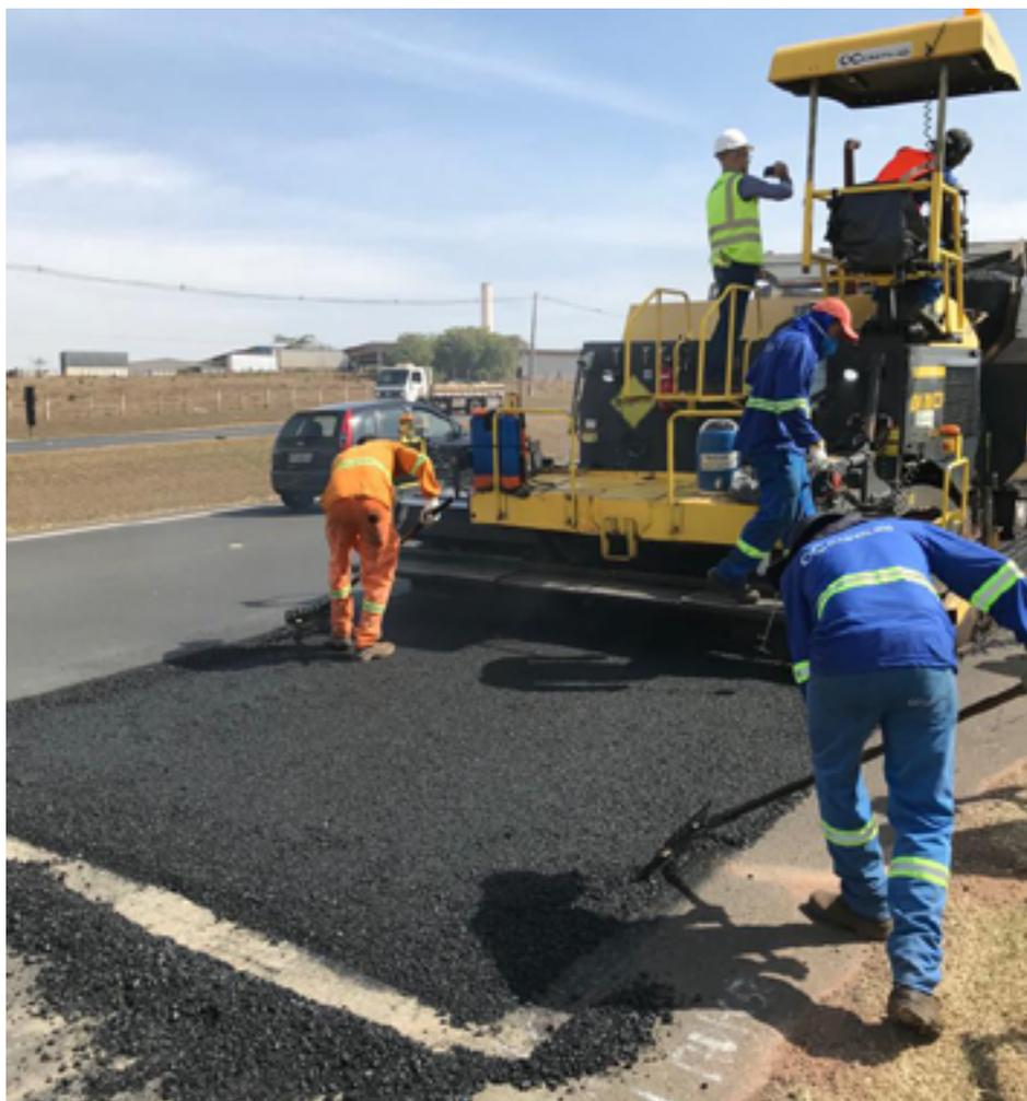
O plástico que seria descartado em aterros é coletado, triturado, reciclado e misturado ao asfalto e pode ser incorporado a uma mistura pelo uso do modificador de asfalto da Dow, o ELVALOY™, que aprimora as características das resinas plásticas utilizadas nas ligas para asfalto e permite a fusão ao material tradicionalmente utilizado para as rodovias.
